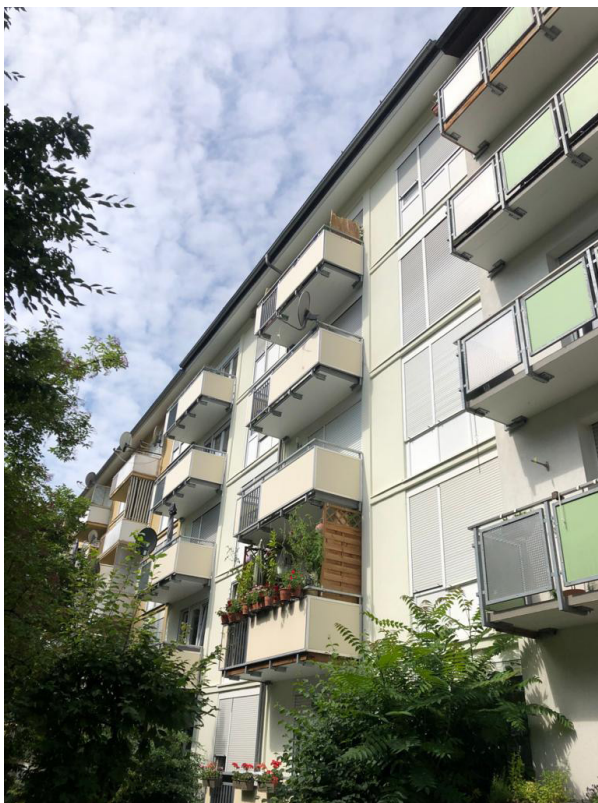
Foto 1: Fassade mit Balkonen
